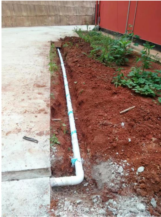
站内员工洗浴废水收集管道
