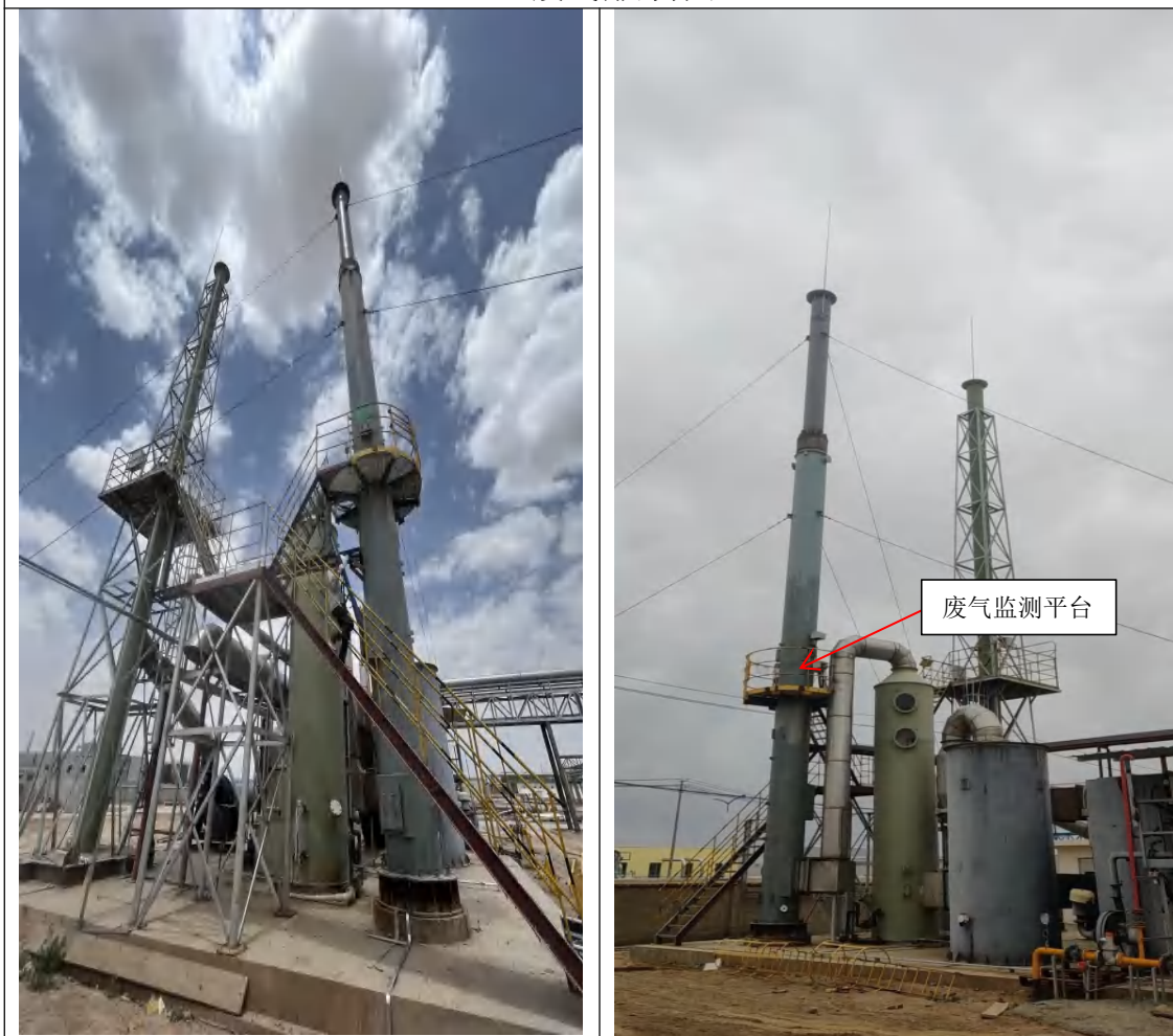
废气排气筒采样孔及监测平台
