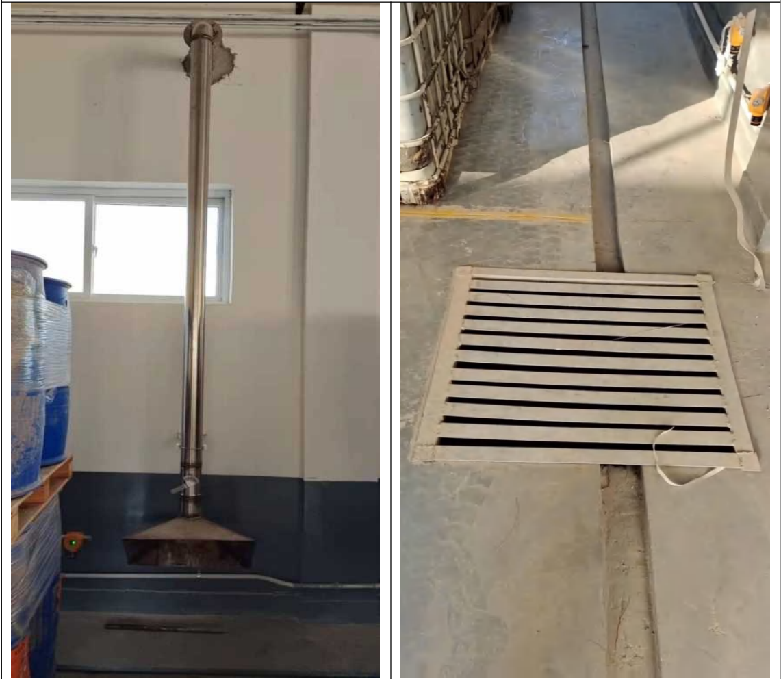
废气收集集气罩
