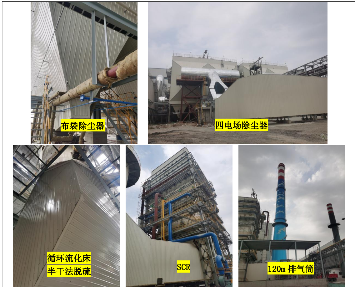
图 3-6 布袋除尘器、四电场除尘器除尘器、循环流化床半干法脱硫+选择性催化还原脱硝(SCR)及 120m 排气筒现场照片
