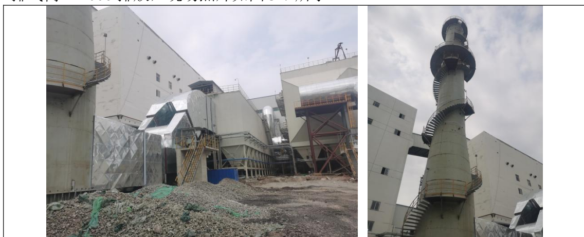
图 3-7 布袋除尘器和 45m 排气筒现场照片
