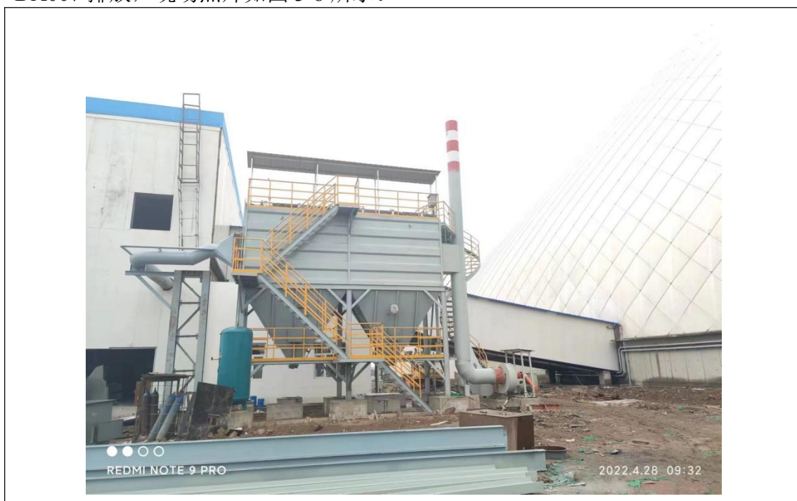
图 3-8 出仓第一个落料点布袋除尘器+15m 高排气筒现场照片
