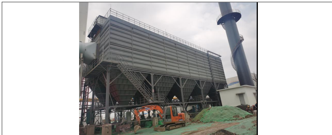
图 3-5 布袋除尘器和 45m 排气筒现场照片
