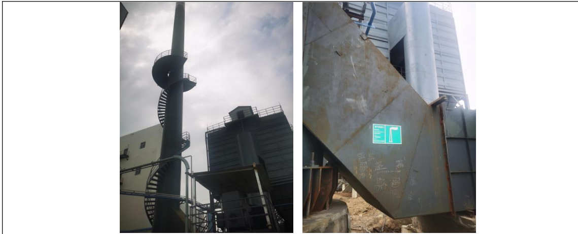
图 3-2 布袋除尘器和 45m 排气筒现场照片
