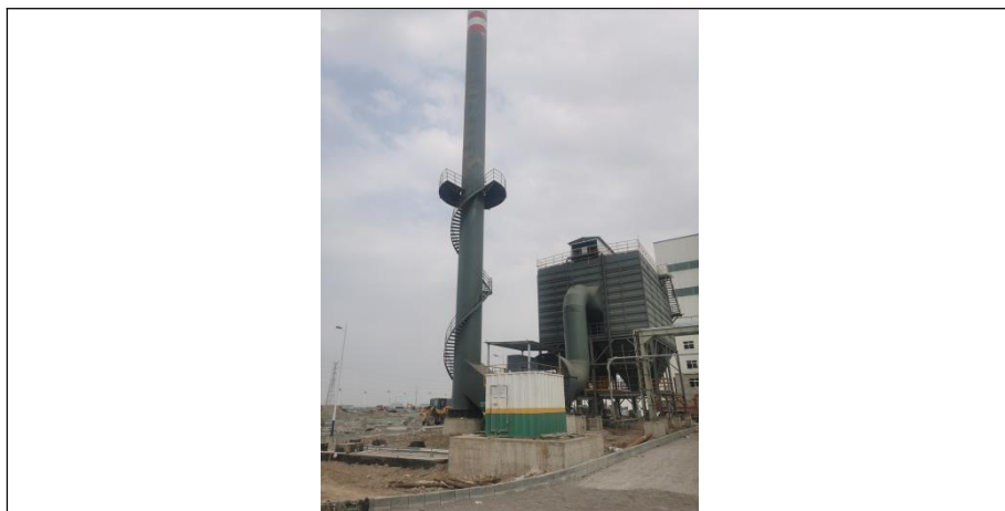
图 3-4 袋除尘器和 45m 排气筒现场照片
