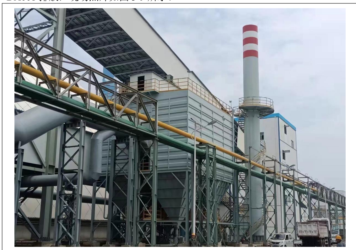
图 3-9 成品转运卸料布袋除尘器+35m 高排气筒现场照片
