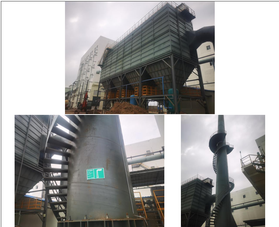
图 3-3 布袋除尘器和 45m 排气筒现场照片
