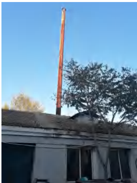
20m 高生物质锅炉排气筒
