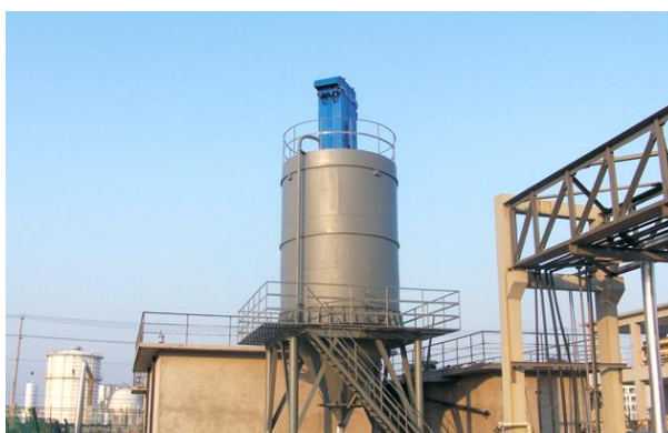
图 4-1 筒仓顶部袋式除尘器设备示意图
