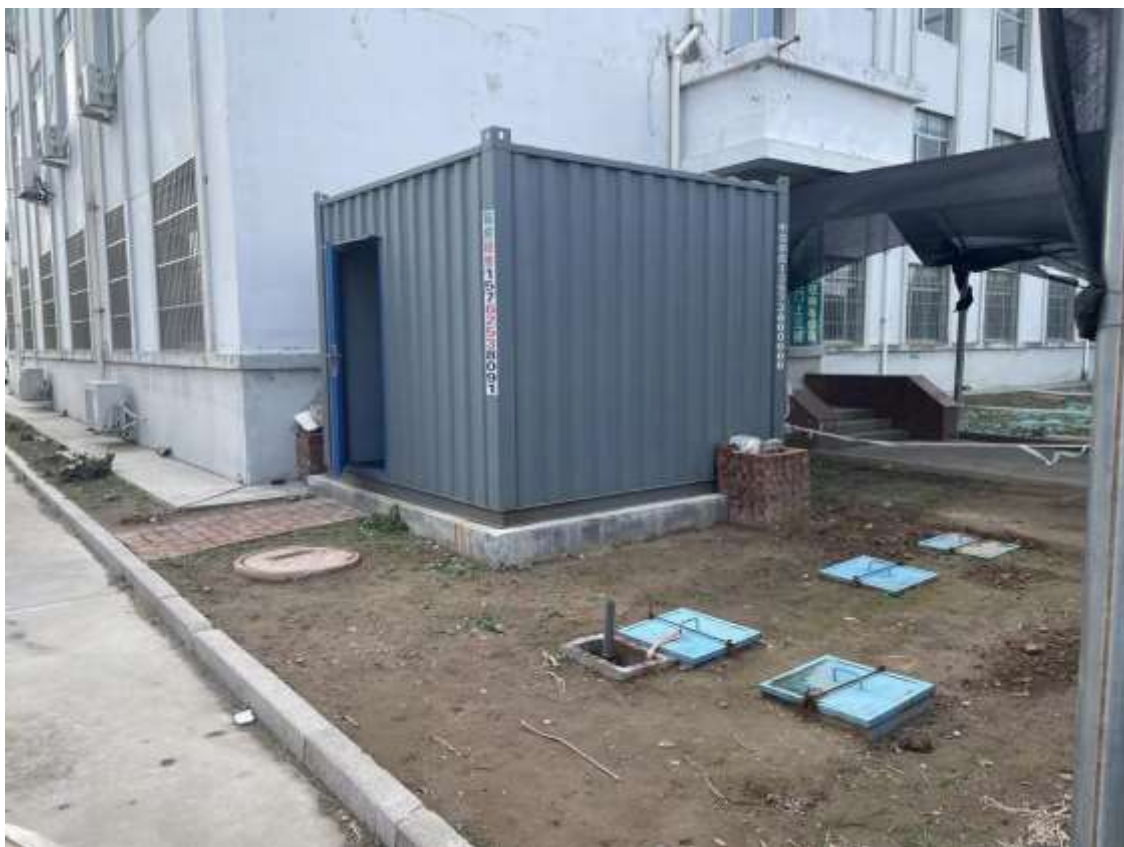
污水处理站+污水处理站排气口
