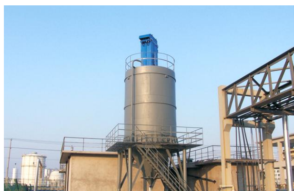
图 4-1 筒仓顶部袋式除尘器设备示意图
