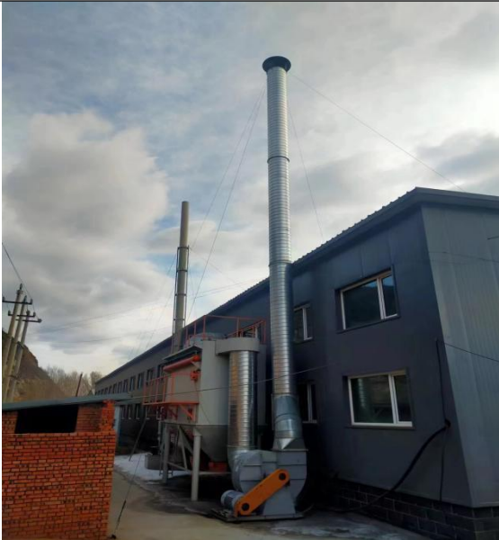
有机肥生产车间（除尘器、15m 高的排气筒）
