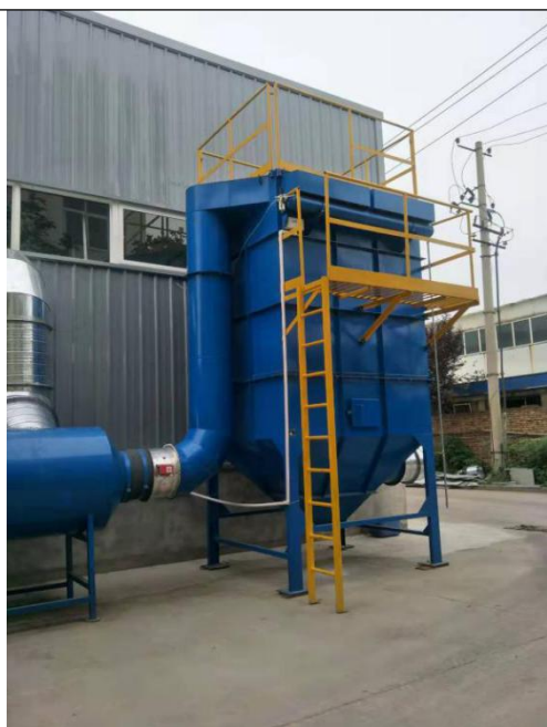
图 3-1 1 套“布袋除尘器+UV 光催化氧化装置+活性炭吸附装置+1 根 15m 高排气筒”（前）
