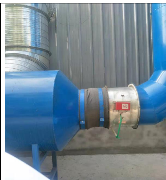
图 3-5 风管软接头
