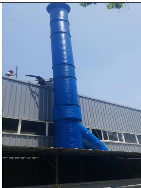
图 3-2 1 套“布袋除尘器+UV 光催化氧化装置+活性炭吸附装置+1 根 15m 高排气筒”（后）
