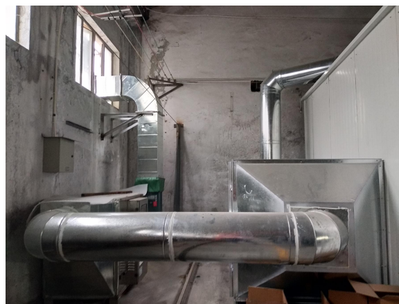
浸漆房废气烟道及活性炭、光氧催化 设施设施
