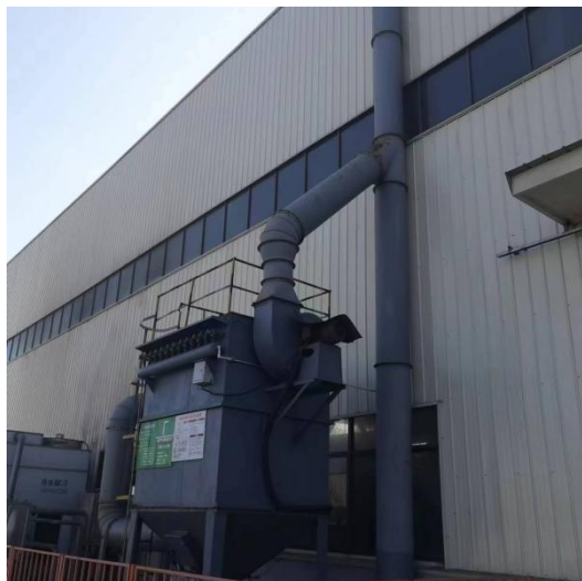
三个混砂机通过两个排气筒排放
