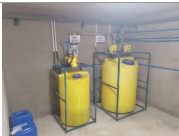
地下机房（消毒药剂间及投加装置）
