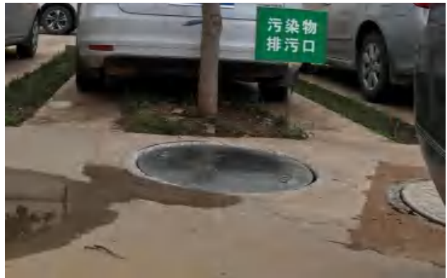
在线监测装置（测量指标为流量）传感器安装位置井口、医院污水排放口
