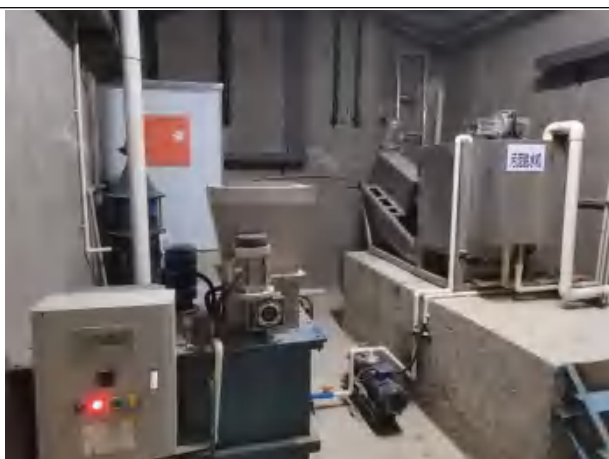
地下机房（污泥脱水间及污泥脱水设备）
