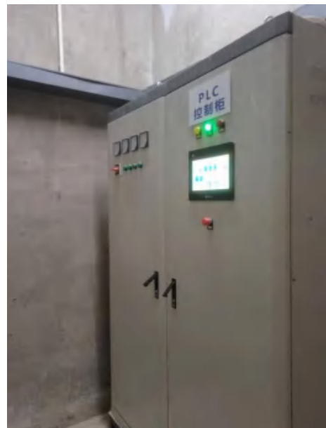
地下机房（控制间及 PLC 系统控制柜）
