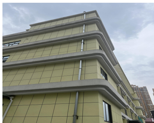
污水处理站废气排气筒
