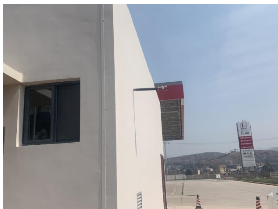
应急发电机废气排口
