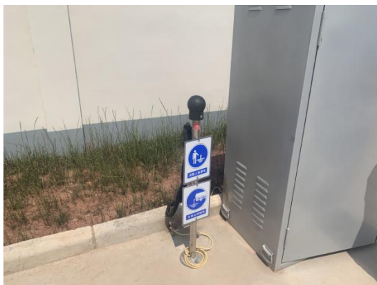
卸油口释放静电装置
