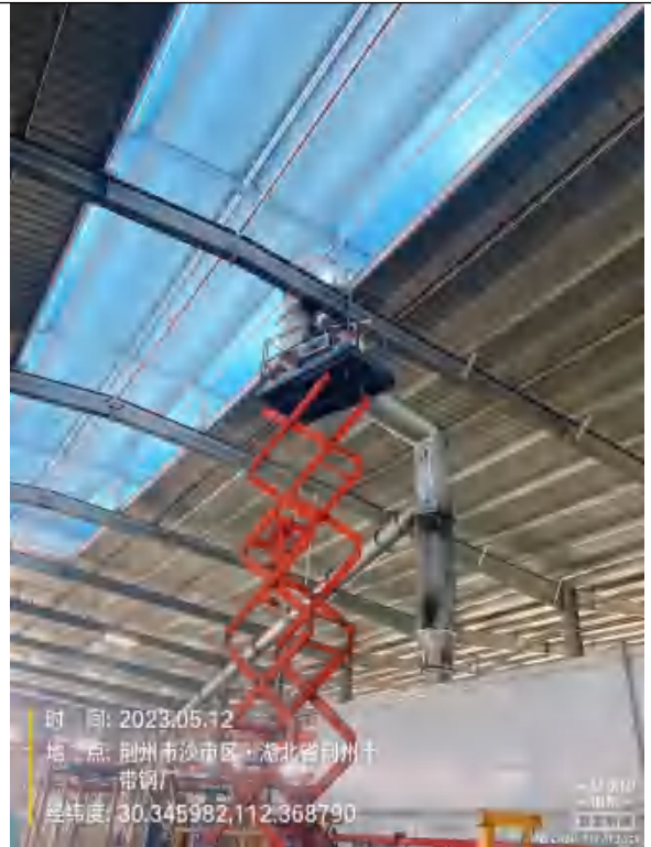
喷涂废气排气筒
