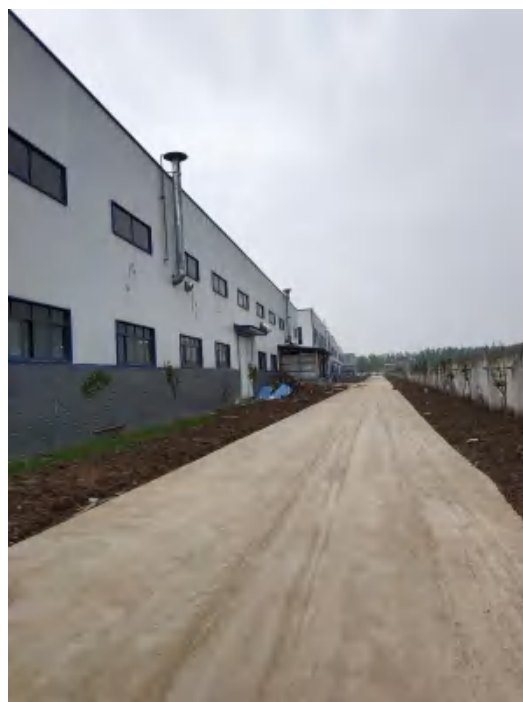
清洗烘干废气排气筒
