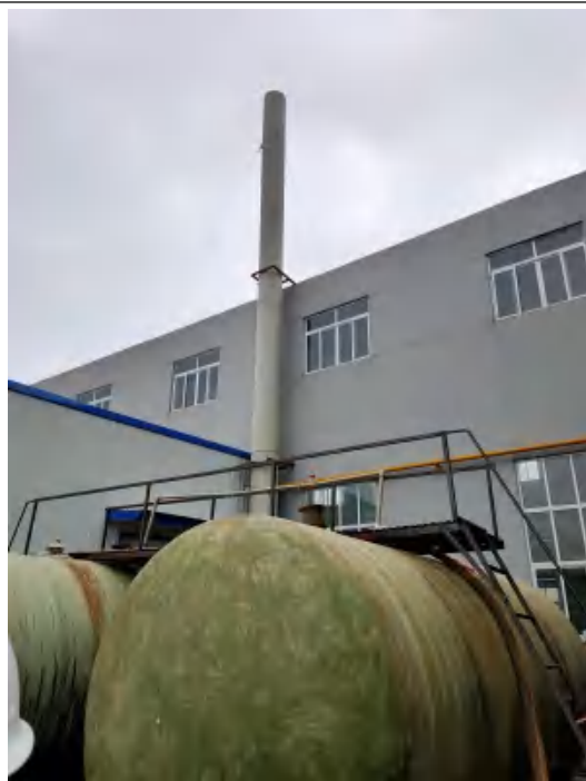
酸洗烘干废气排气筒
