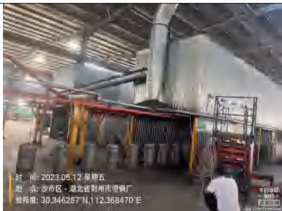
喷涂烘干废气排气筒
