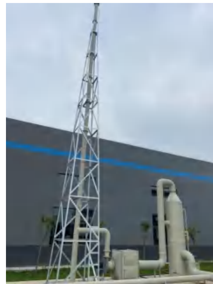
污水处理站废气处理设施及排气筒
