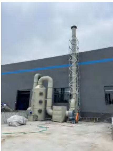
1#车间废气处理设施及排气筒
