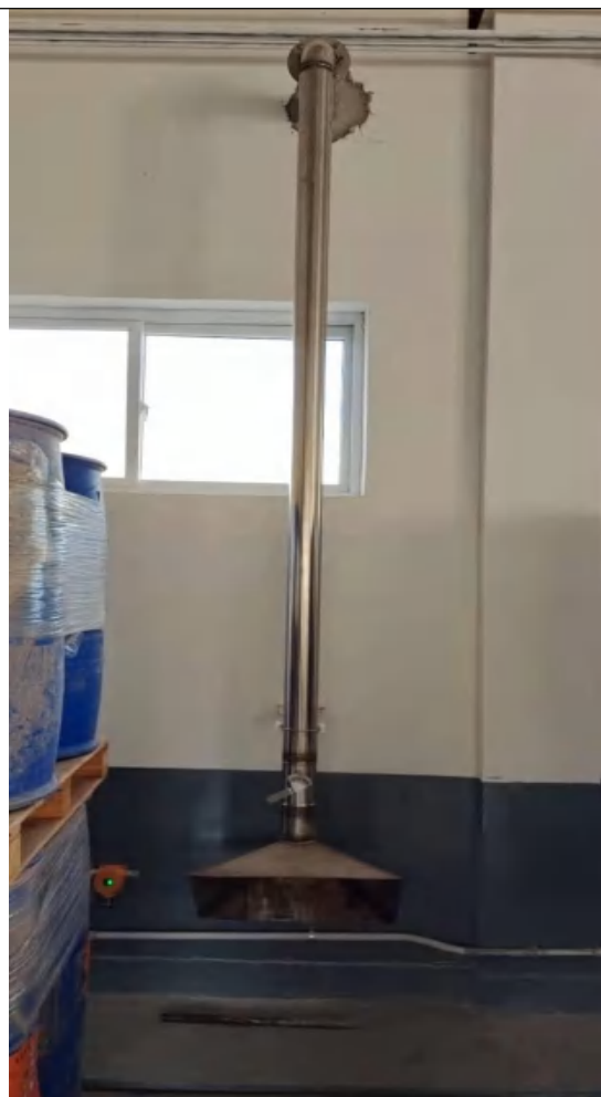
危废暂存间废气收集集气罩
