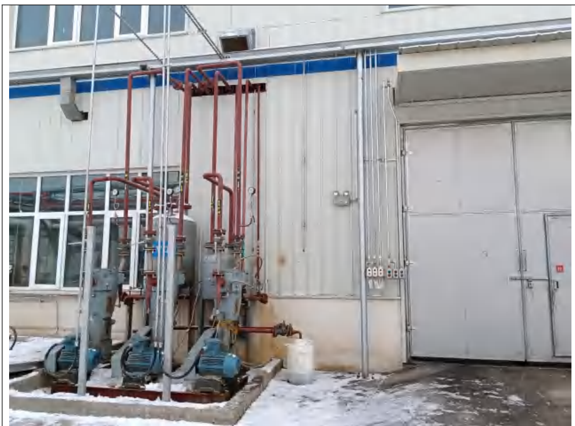
隔声措施（电机置于厂房外）
