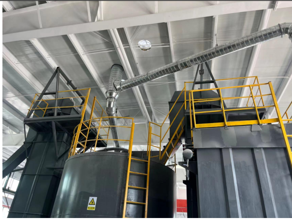
投料、破碎、包装粉尘处理设施
