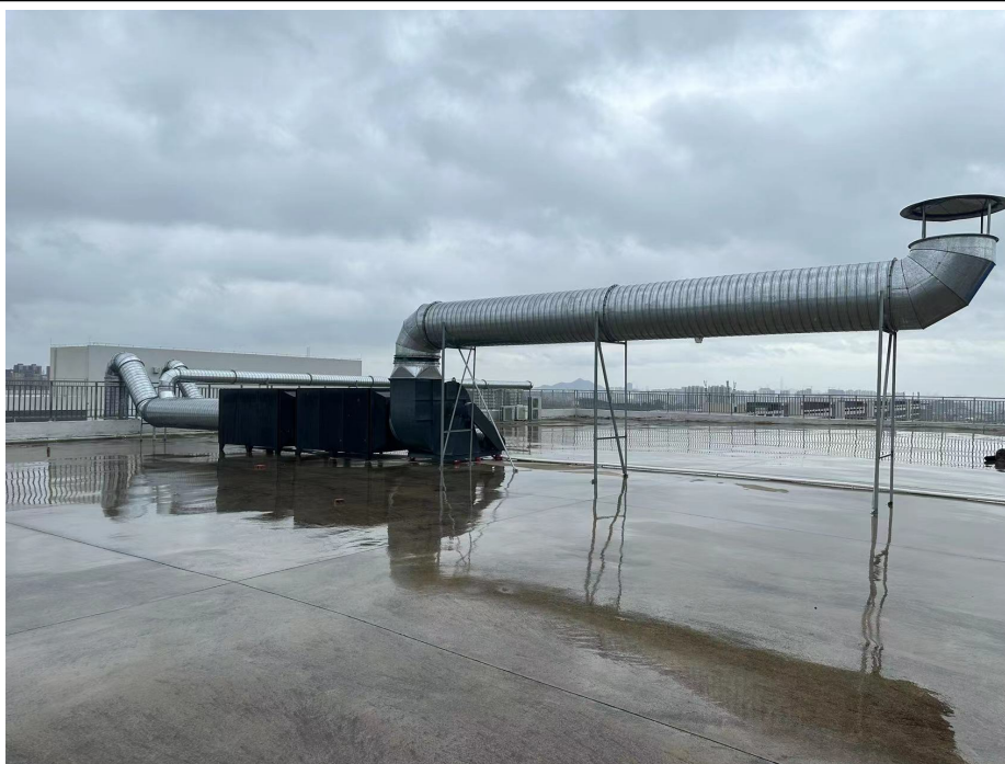
点胶、过孔、烘烤、移印工序废气排放口（二级活性炭吸附装置）
