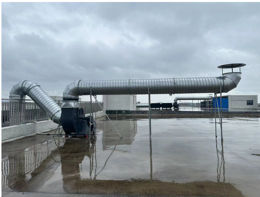
浸锡、焊接工序废气排放口（高空排放）
