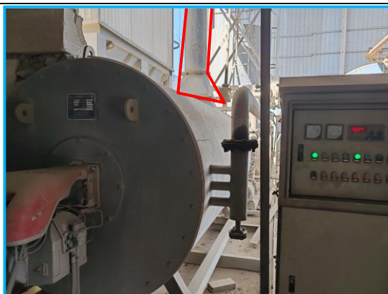
导热油炉+2#排气筒
