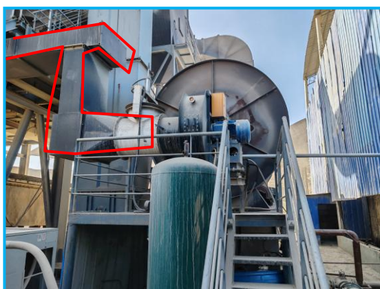
搅拌缸废气收集管道
