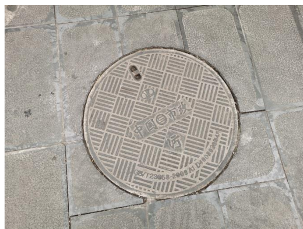
项目接入的市政污水管网
