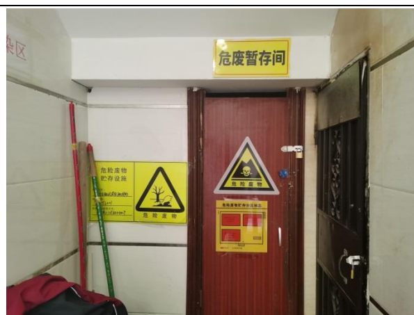
危险废物暂存间
