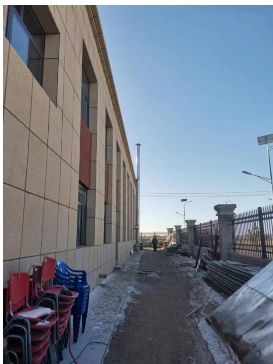
油烟废气排气筒，高度高于房顶，满足标准要求
