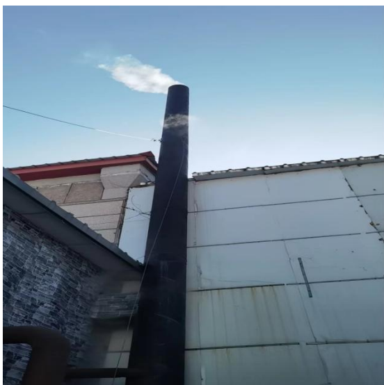
生产线 15m 高排气筒照片
