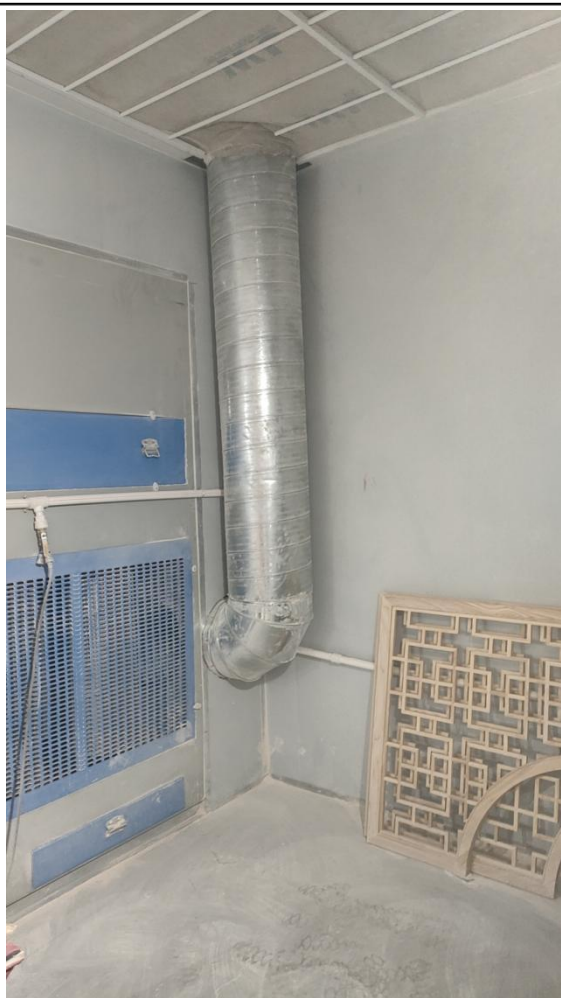
木料下料、细加工、打磨工序干式除尘柜
