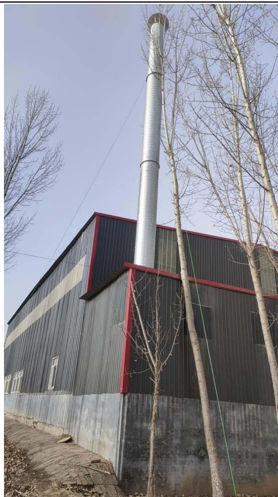
木料下料、细加工、打磨工序排气筒
