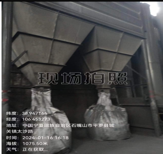
破碎工序布袋除尘器
