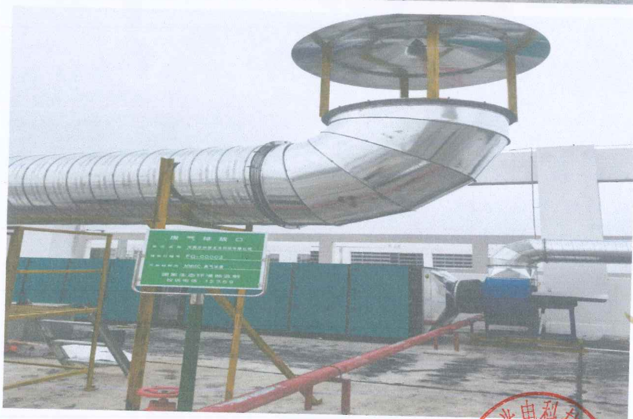
丝印工序有机废气环保处理装置：二级活性炭吸附装置
