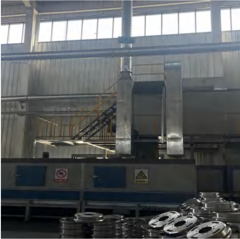
低氮燃烧+1 根 18m 排气筒 DA006
