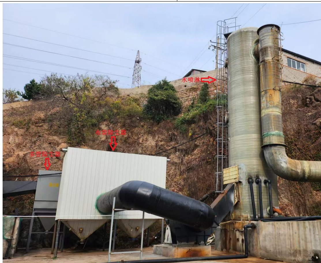
多管除尘器+布袋除尘器+水喷淋处理设施
