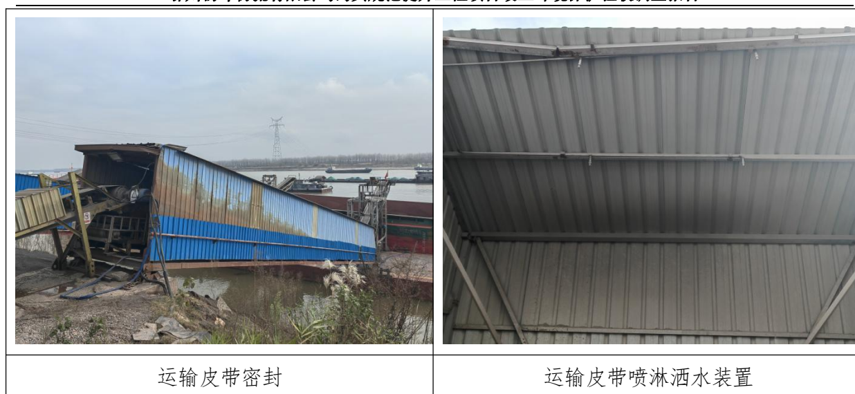
图 4-1 项目废气处理设施
