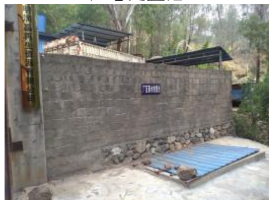
厂区雨水收集池
