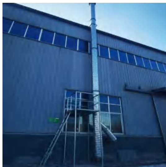
两级活性炭吸附装置（TA001）+1 根 15 米高排气筒（DA001）
