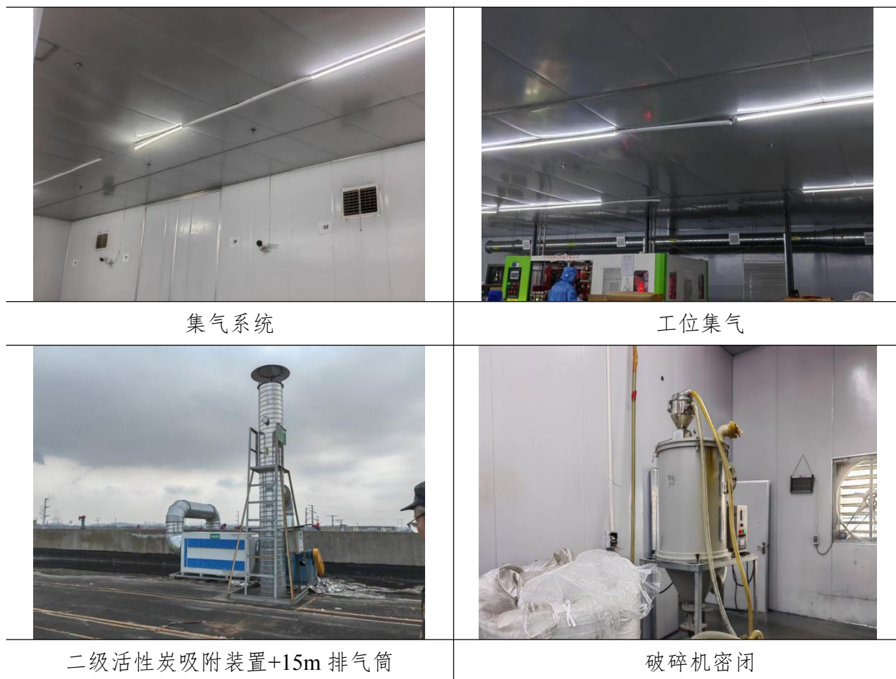
图 4-2 项目废气处理设施
