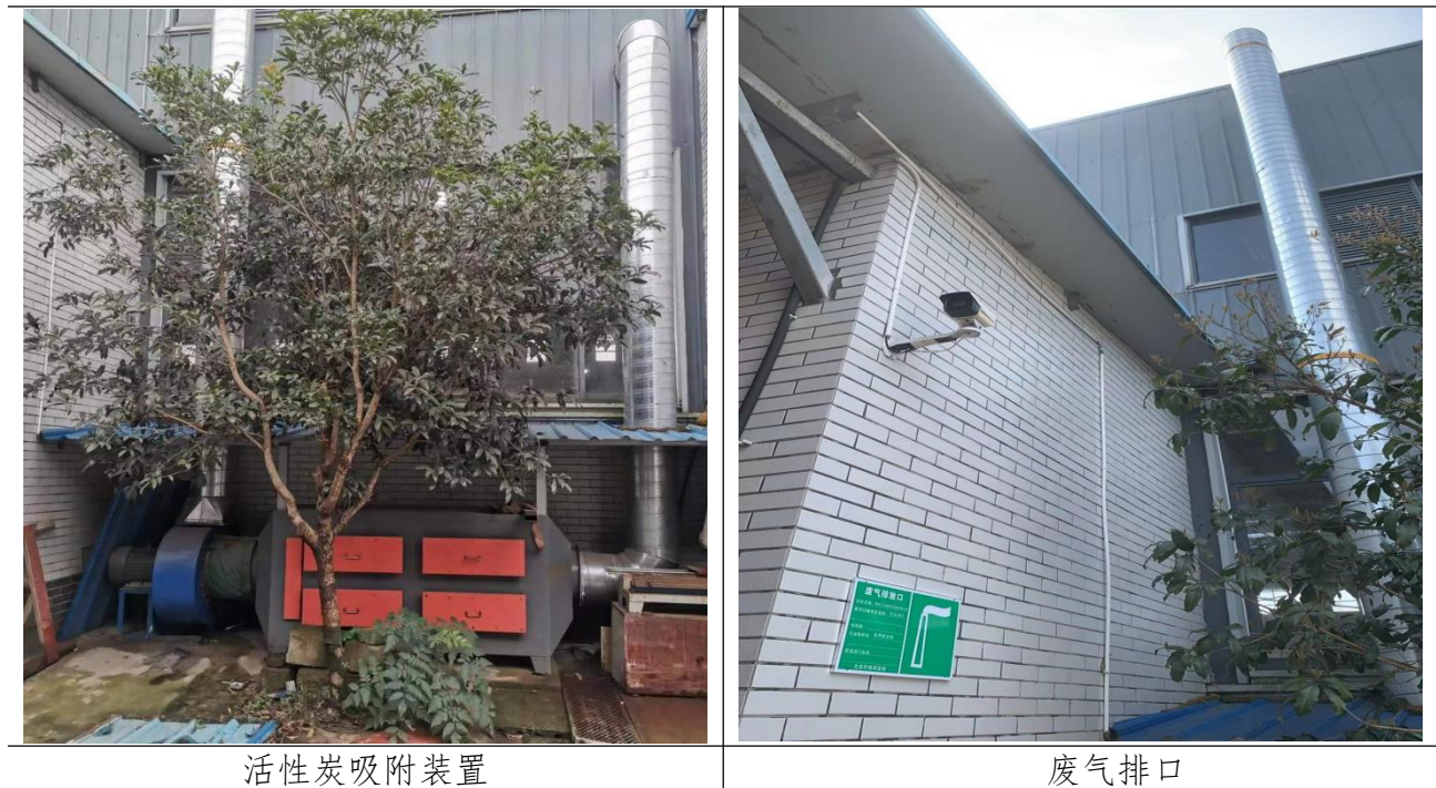
图 4-2 项目废气处理设施
