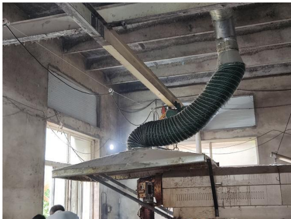
图 1 挤出工序集气罩
