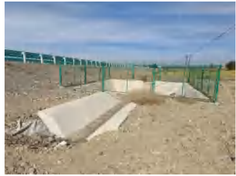
察南渠桥桥面径流收集系统、应急事故池、防撞护栏、防抛网
