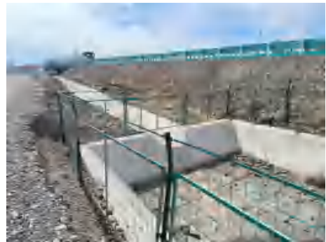
南岸干渠桥桥面径流收集系统、应急事故池、防撞护栏、防抛网
