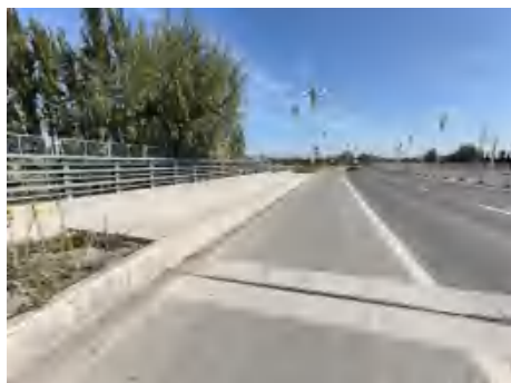
大踏渠桥桥面径流收集系统、应急事故池、防撞护栏、防抛网
