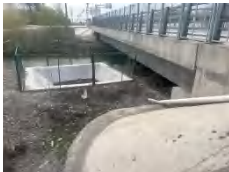
大踏渠桥桥面径流收集系统、应急事故池、防撞护栏、防抛网
