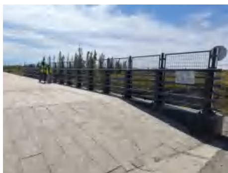
察布查尔渠桥桥面径流收集系统、应急事故池、防撞护栏、防抛网
