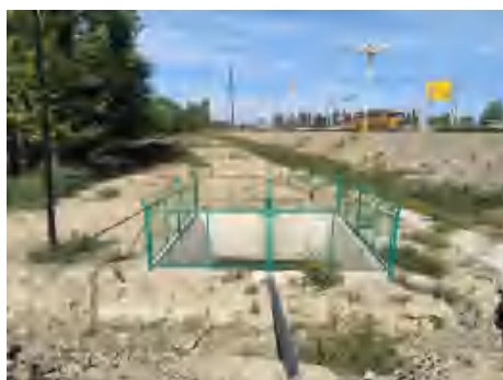
察布查尔渠桥桥面径流收集系统、应急事故池、防撞护栏、防抛网
