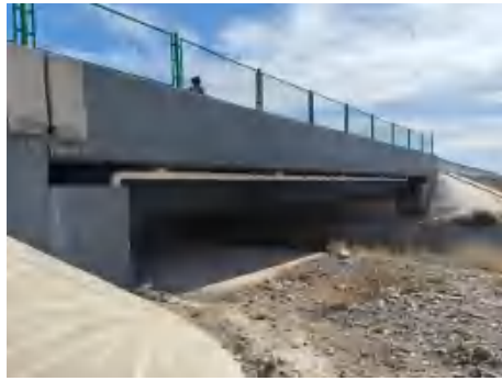
察南渠桥桥面径流收集系统、应急事故池、防撞护栏、防抛网
