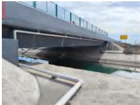
南岸干渠桥桥面径流收集系统、应急事故池、防撞护栏、防抛网
