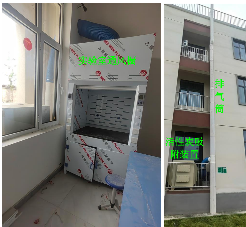
图 3.1-3 实验室废气治理设施图
