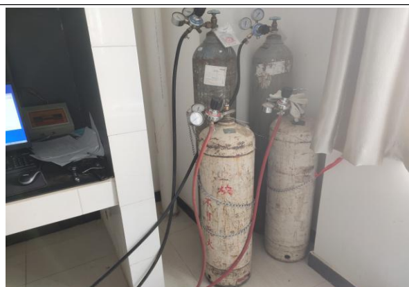
二十七、钢瓶采用铁链固定存放
