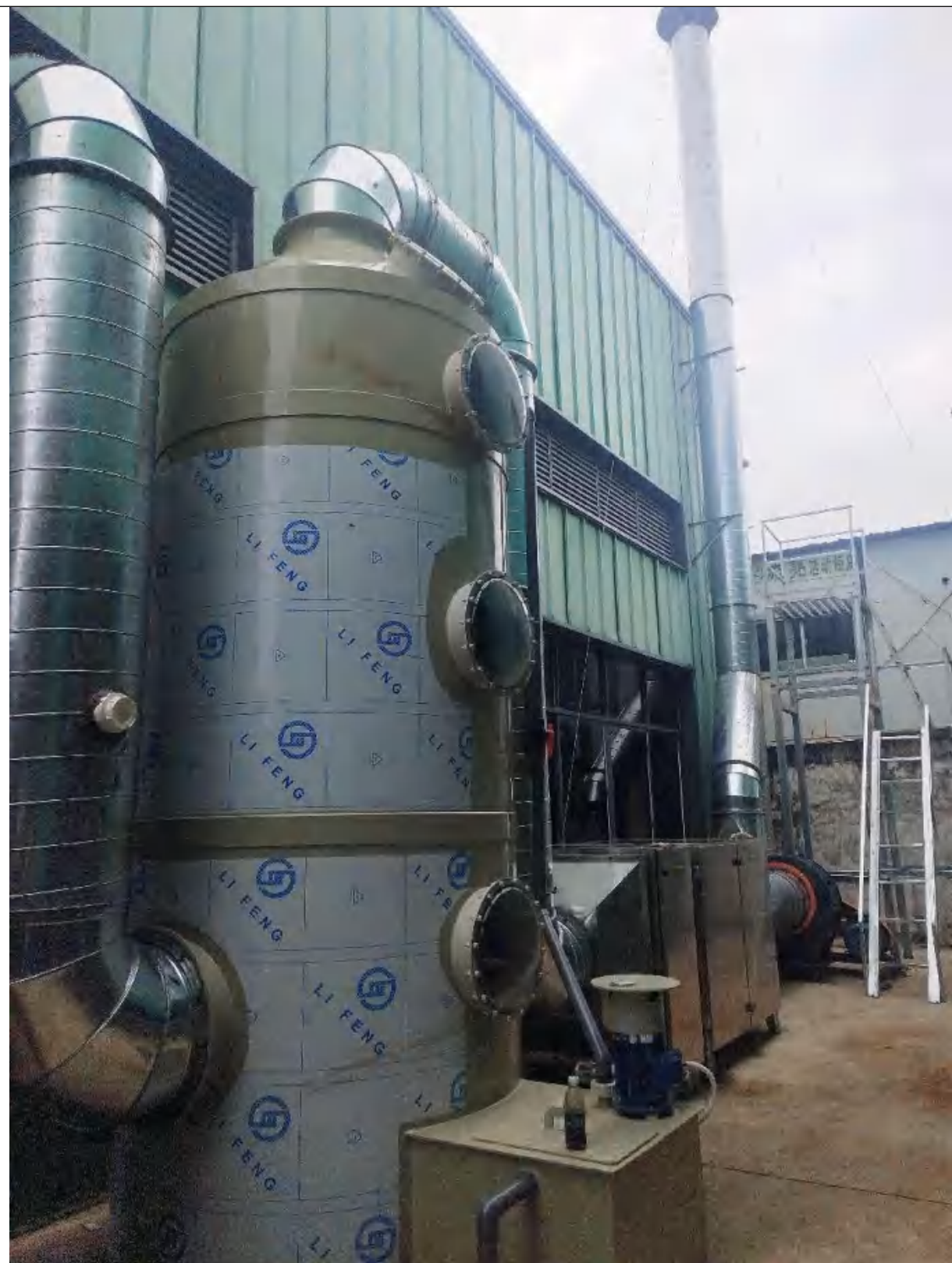
DA001 废气处理设施现场图片
