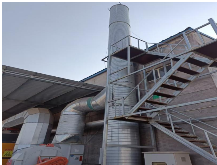
喷淋塔+干式过滤箱+活性炭吸附、脱附+催化燃烧设备+15m 高排气筒 (DA002)
