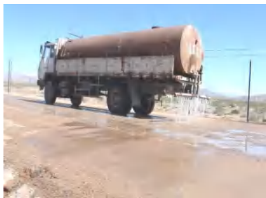
图 8.1 施工便道洒水抑尘
