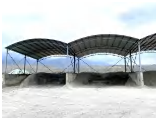
图 8.3 拌合站密闭拌和、场地硬化、料仓围挡
