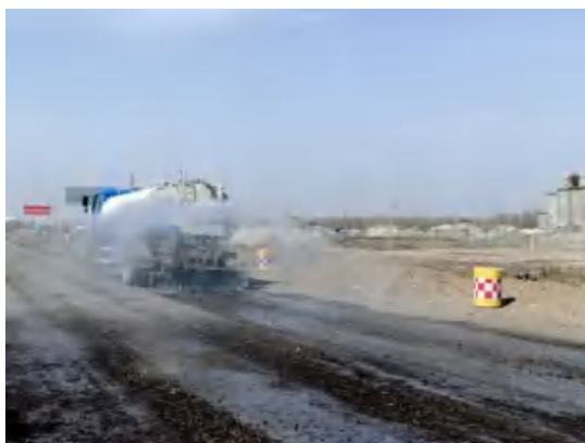
图 8.1 施工便道洒水抑尘
