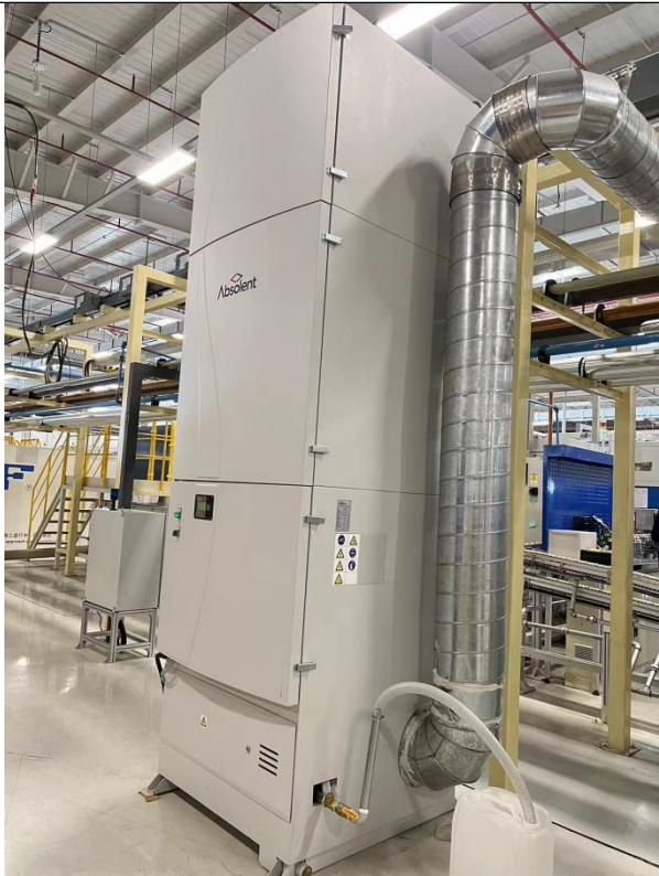
生产线废气处理设施
