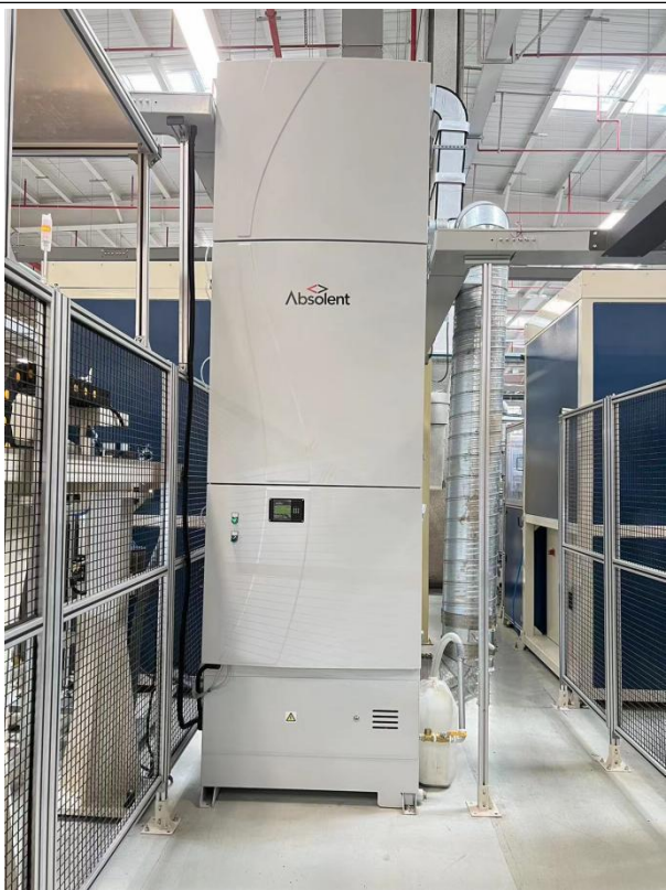
生产线废气处理设施
