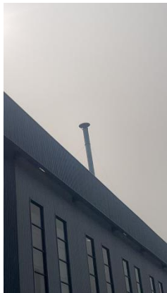
图 6 配料、搅拌工序废气排气筒
