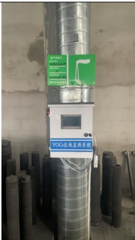
图 1 烘干工序密闭收集装置
