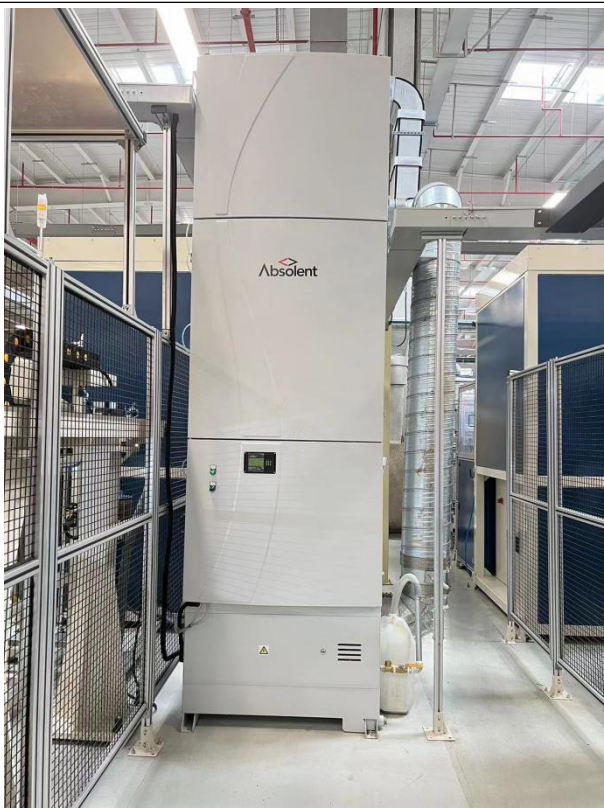
生产线废气处理设施
