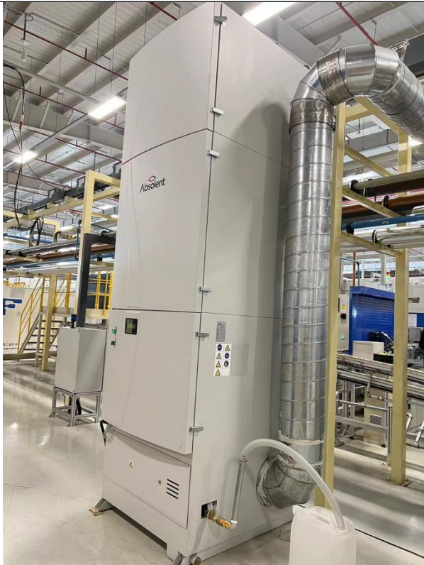
生产线废气处理设施
