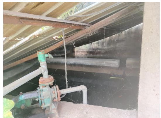
二十四、沉淀池
