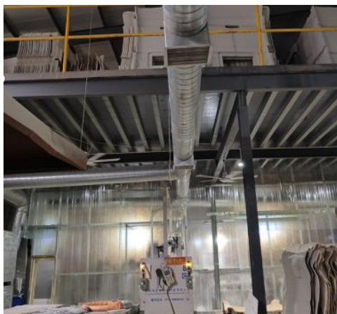
图 6 车间顶吸装置
