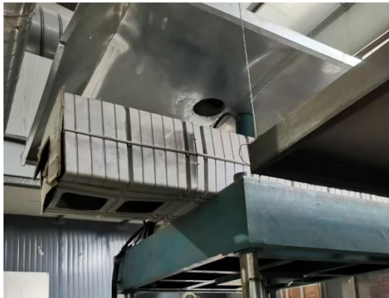
图 1 加热工序集气罩
