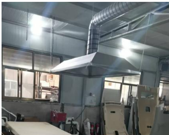
图 1 加热工序集气罩
