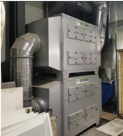
图 2 喷胶工序集气罩
