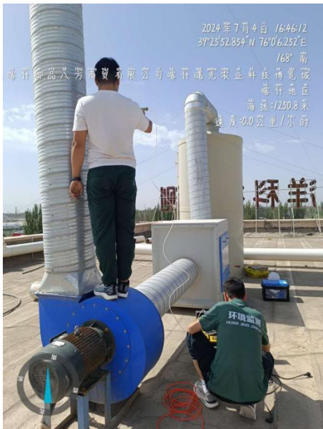
图 3-1 碱液喷淋净化塔
