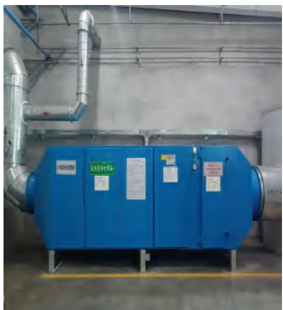
“UV 光氧光催化+活性炭吸附”净化装置处理
