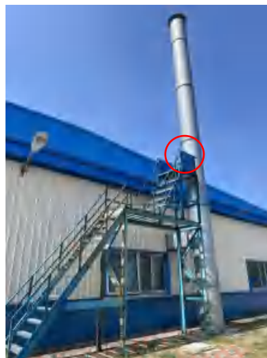
DA001 排气筒采样平台及采样口
