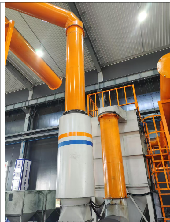
铜箔等原料综合利用生产线—布袋除尘器
