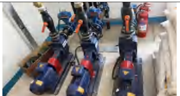
产水泵、反洗水泵
