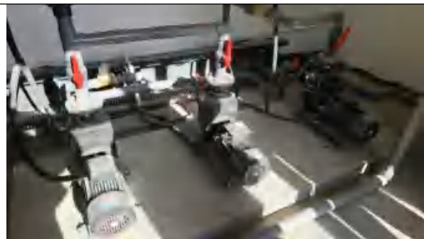
产水泵、反洗水泵
